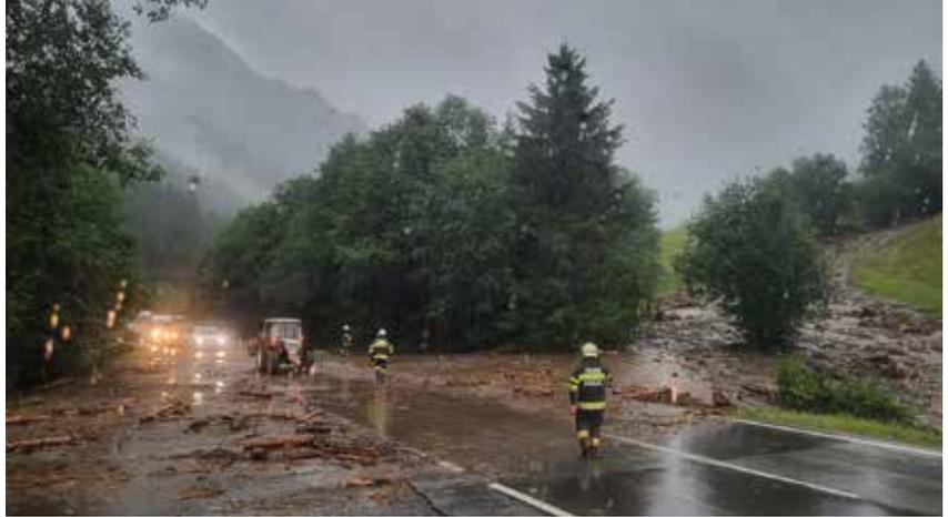
Bei Kilometer 7,4 wurde ein größerer Durchlass verstopft und dadurch das Geröll, Schlamm und Wasser direkt auf die Bundesstraße geleitet.
